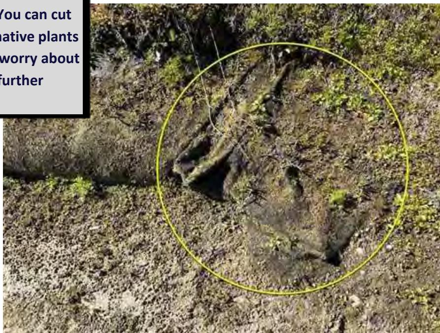
Filter fabric tear exposing fill material.
